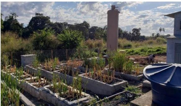
Figura 1 - Wetlands Construído vegetado com taboas em fase de crescimento.
