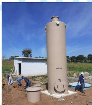
Figura 3 - Reator UASB + Filtro de Gás com carvão ativado.
