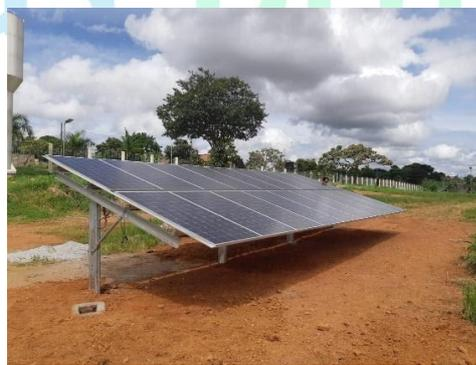
Figura 4 - Placas Fotovoltaicas a serem resfriadas com efluente tratado.
