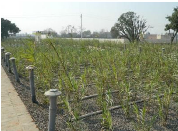
Figura 12 - Tubos de aeração e de distribuição de esgoto.
