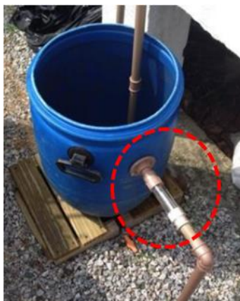
Figura 27 - Aparato medidor de vazão, com destaque ao tubo de extravasamento.
