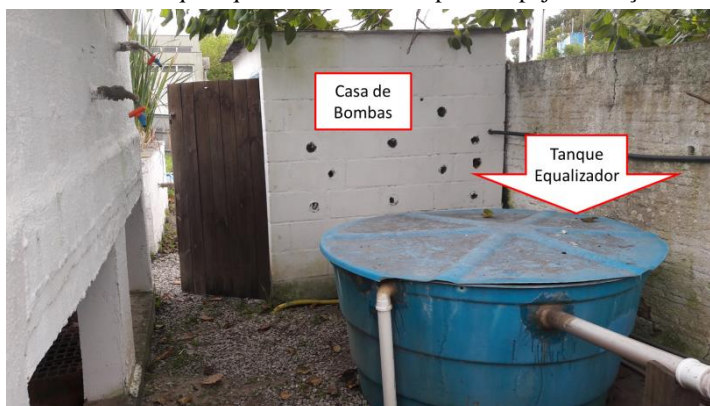
Figura 29 - Vista do tanque equalizador utilizado para despejo do traçador.
