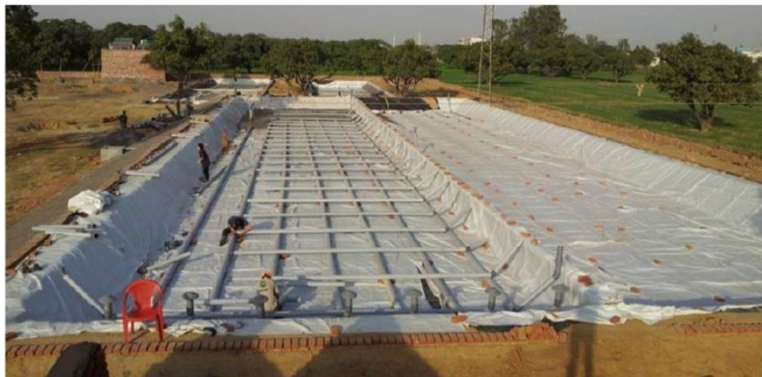
Figura 11 - Tubos de drenagem de efluente tratado.
