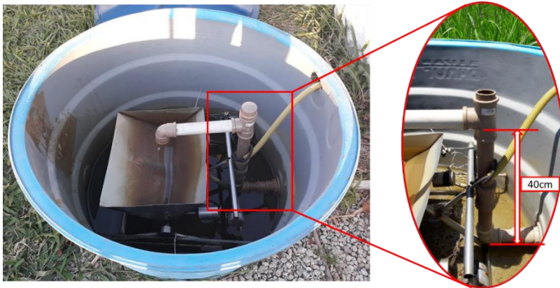
Figura 23 – Controlador de nível do WCV-FS.
