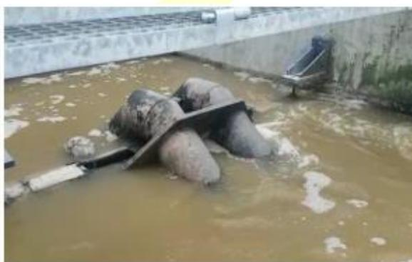
Foto 1 - Caixa de armazenamento de esgoto bruto (após a alimentação). Destaque para o sifão auto-escorvante.
