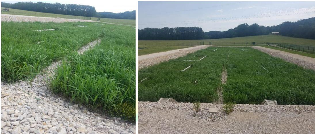
Foto 3 - Primeiro estágio do wetland construído de fluxo vertical - sistema Francês aerado.
